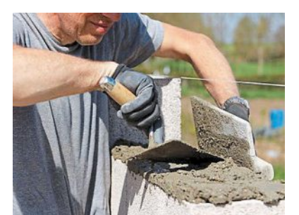
Un maçon sur un chantier.
