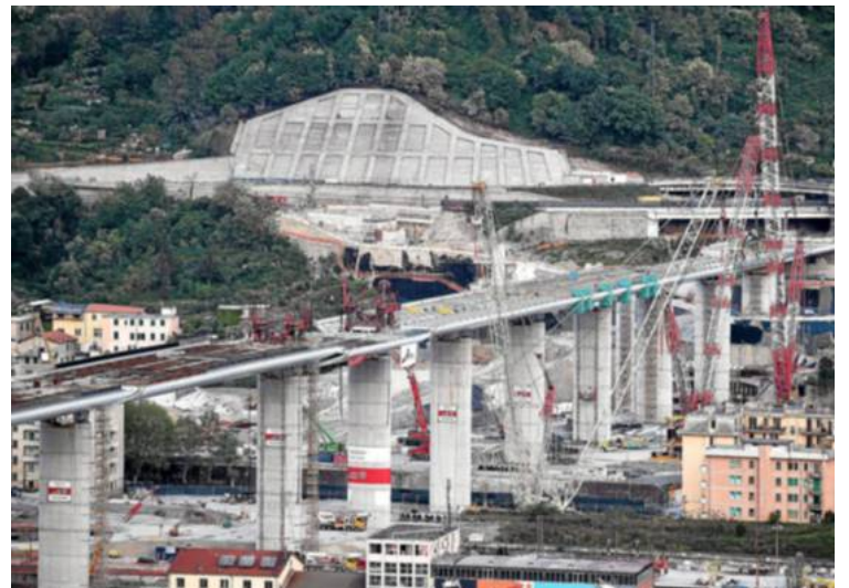
La pose du dernier tronçon du pont, commencée lundi. Luca Zennaro/EPA
