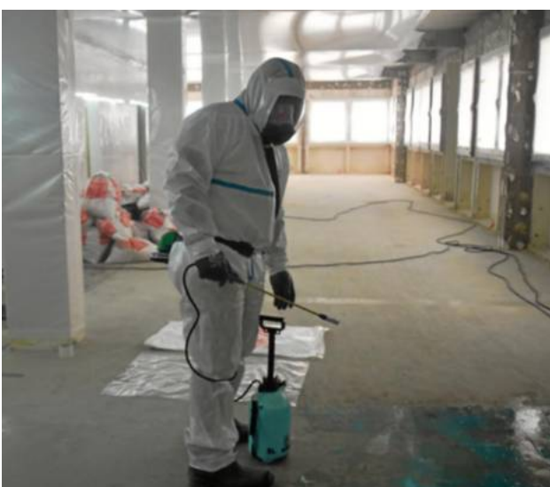
Les opérateurs procédant au désamiantage sont équipés de masques et de combinaisons.
